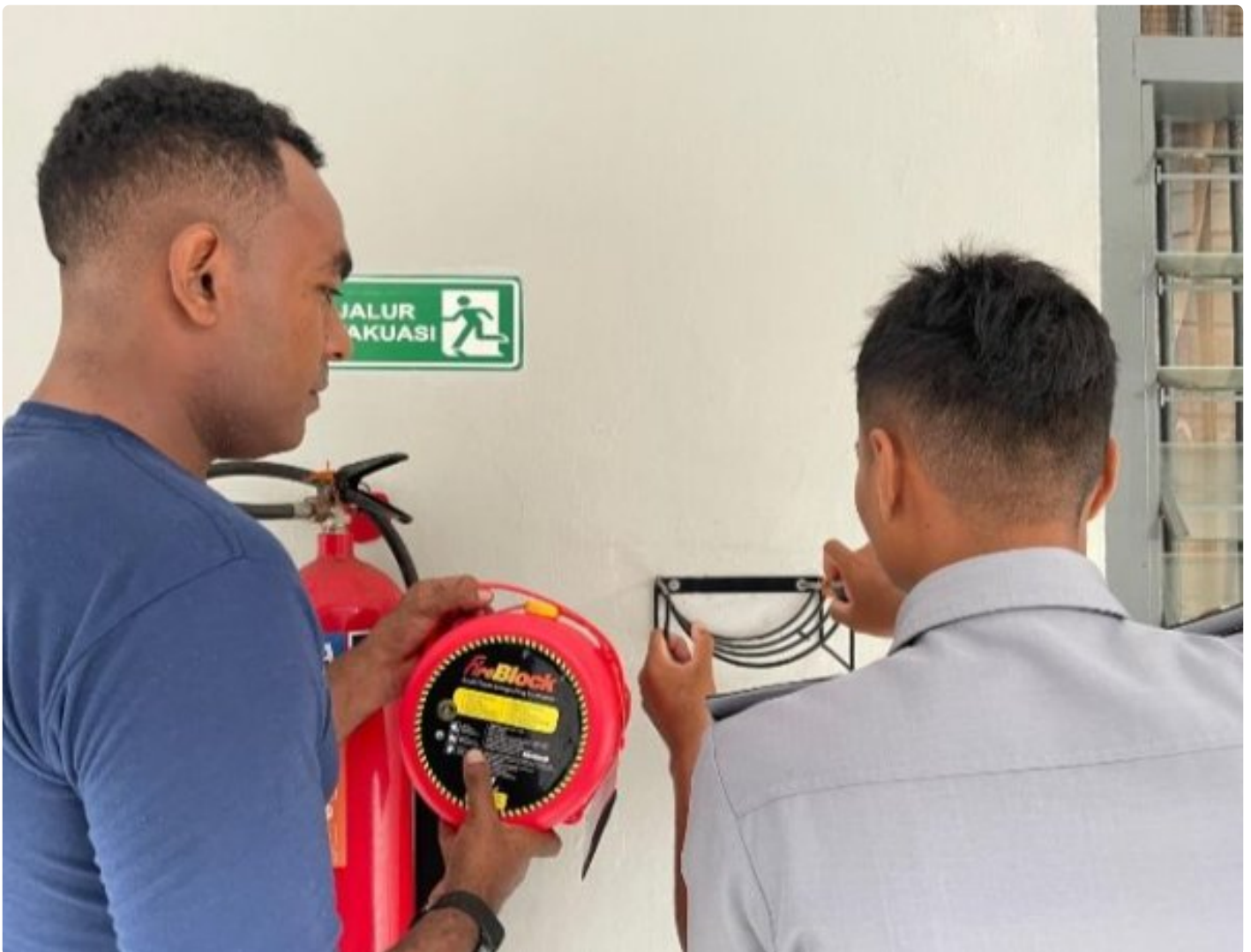
Antisipasi Kebakaran, Lapas Besi Tambah Pemasangan Fireblock
